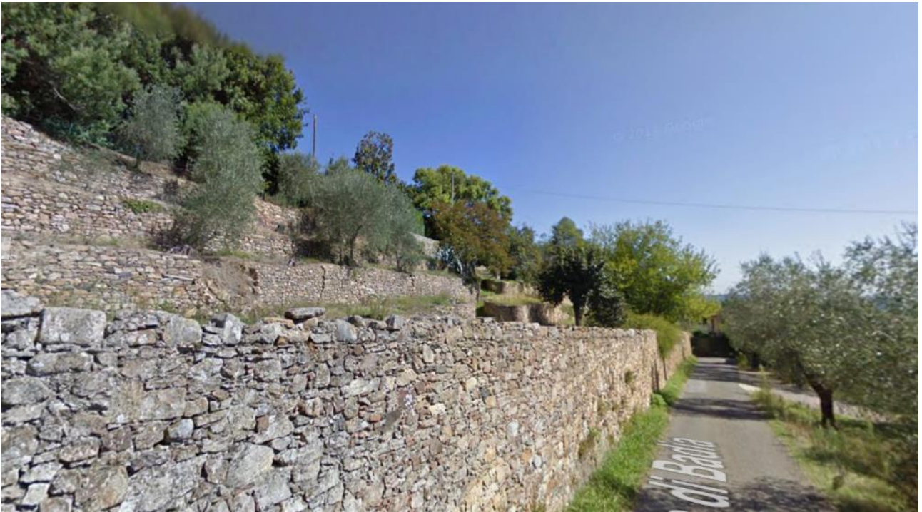
Figura 47 Vista dell'area di interferenza fonte Google Street View
