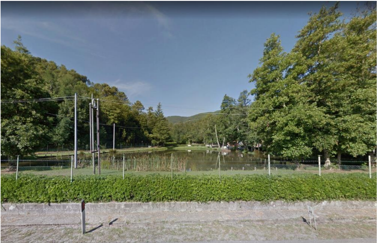
Figura 53 Vista dell'area di interferenza, fonte Google Street View
