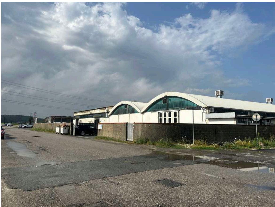
Foto 3 Immobili Slimec srl da Via S. Piero direzione Pontedera
