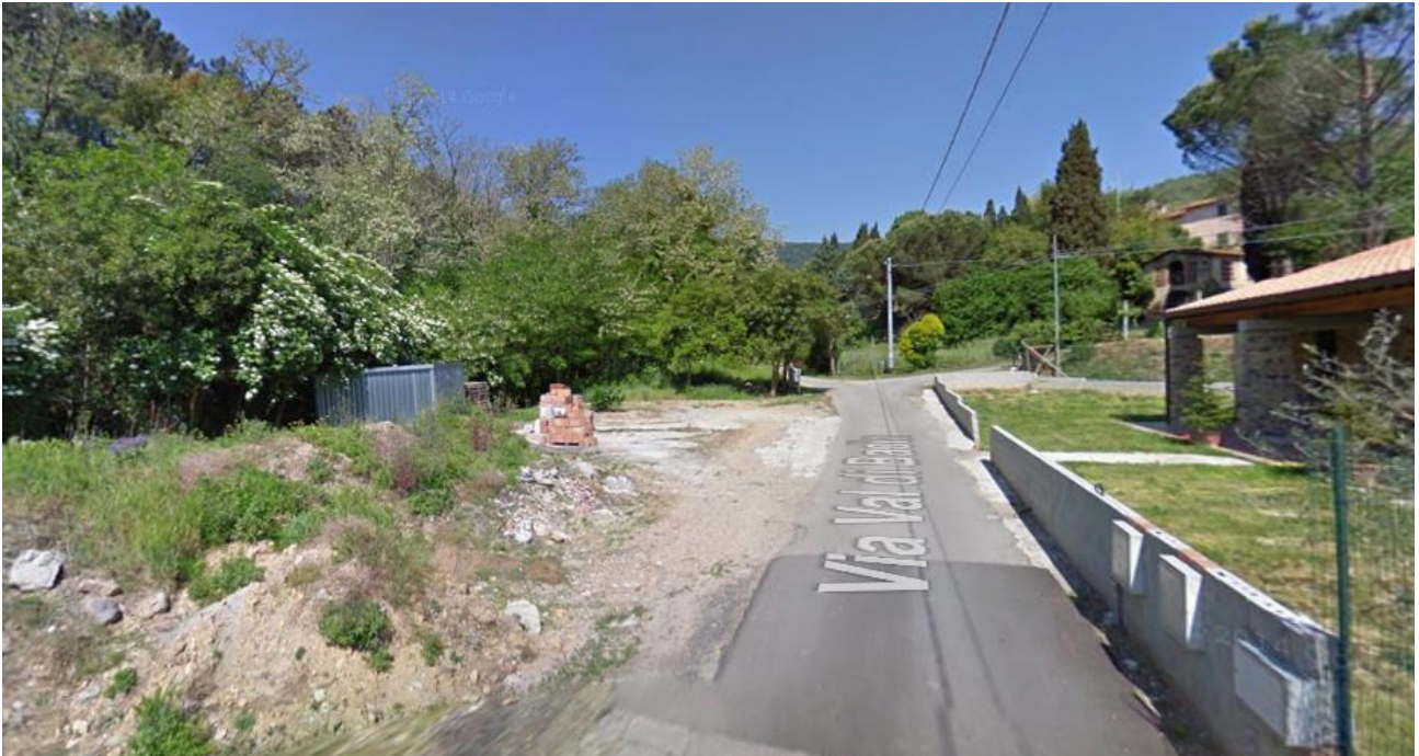
Figura 26 Vista dell'area di interferenza fonte Google Street View.
